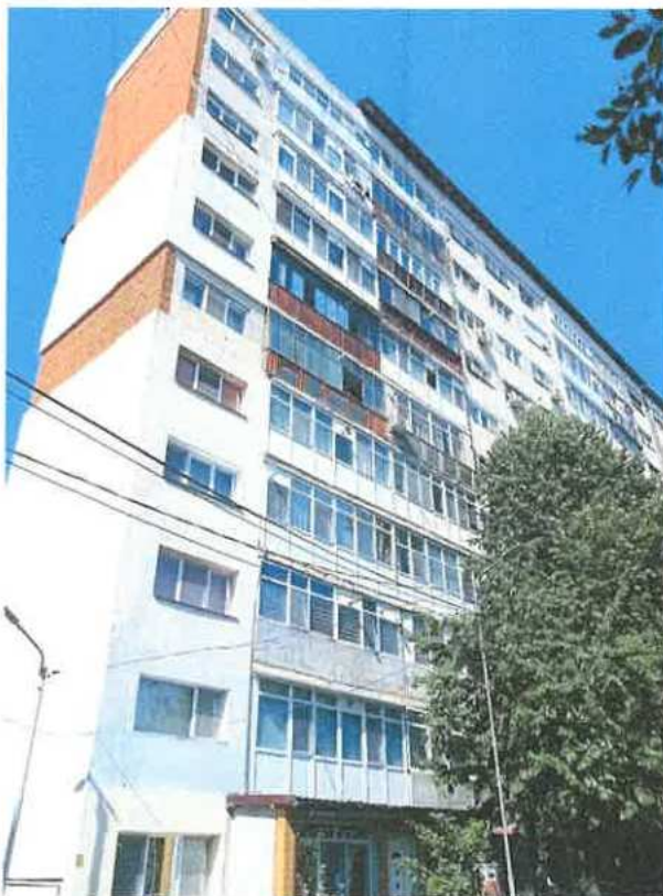
Figură 1 – Lucrari de termoizotatii discontinue si tamplarie exterioara de diverse forme, materiale si culori.
